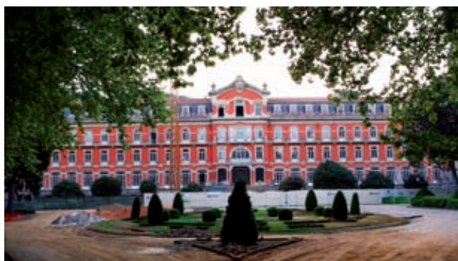
Fachada do Vidago Palace Hotel, ainda em obras mas que reabre em Julho.
